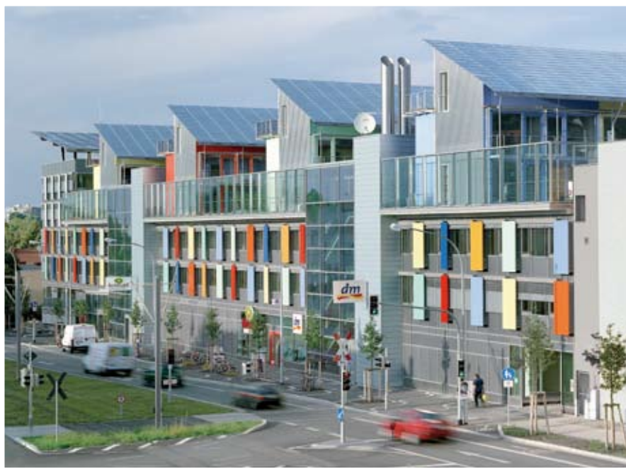
Solceller och solfångare på taken försörjer invånarna i Vauban med energi i överflöd.
